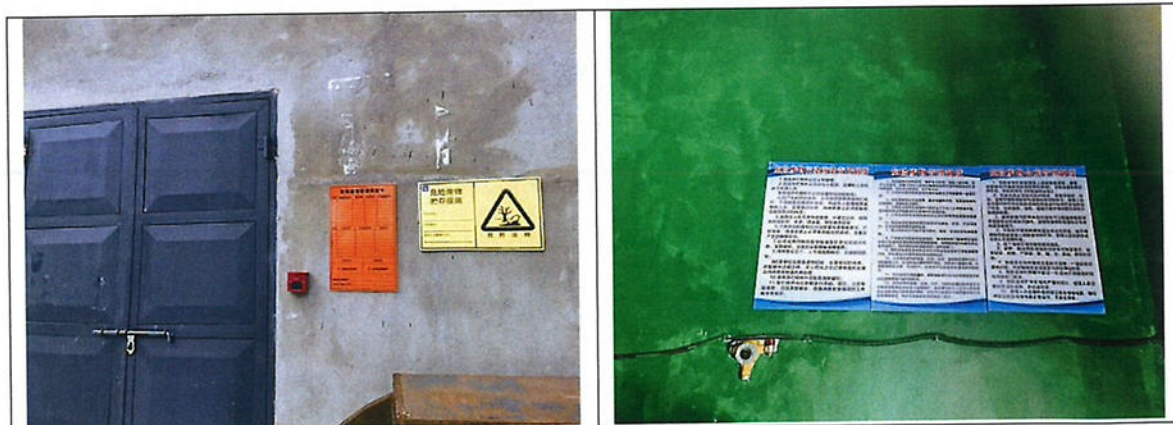
图 4.6-1 危废暂存库照片
