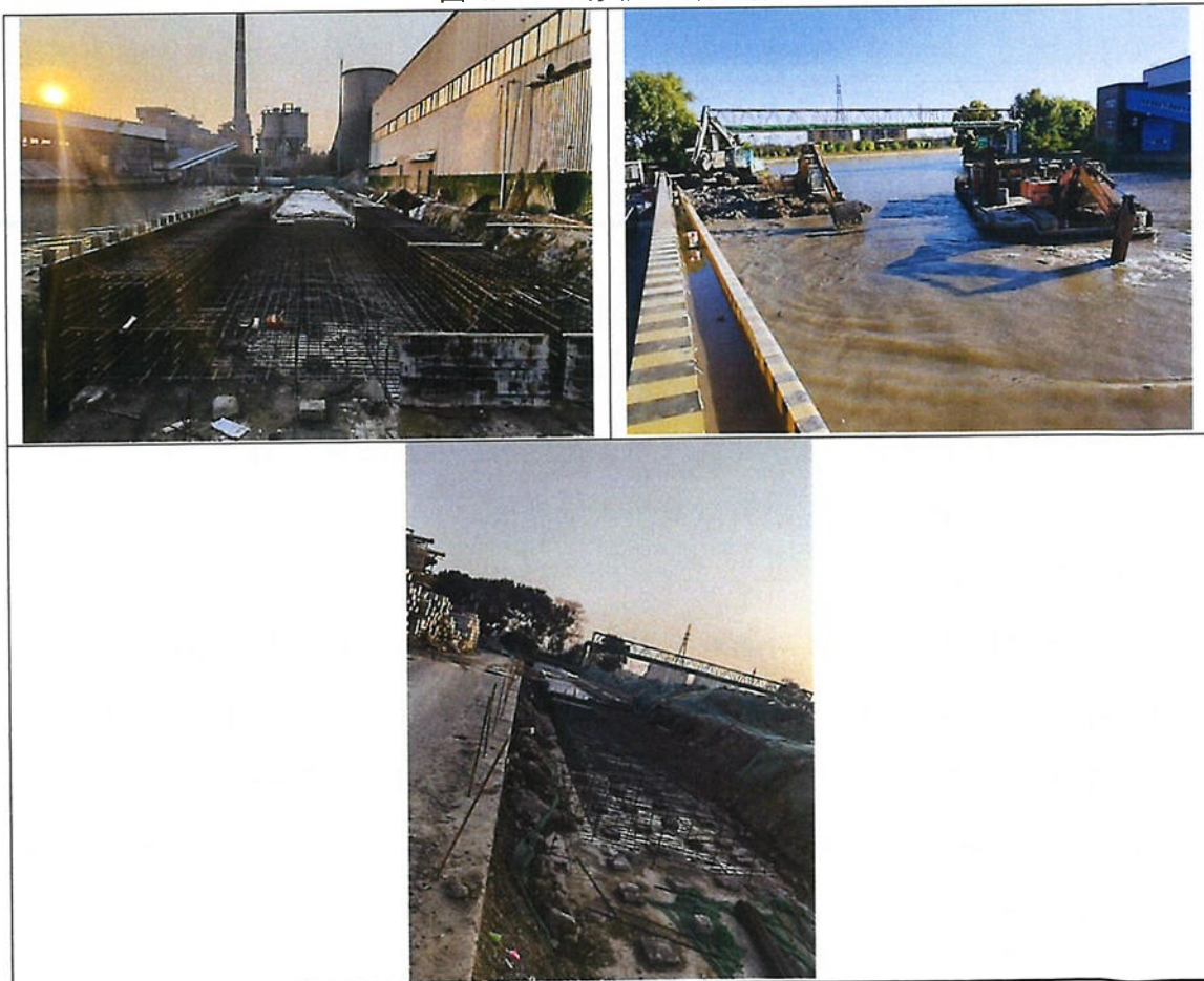
图 4.4-3 码头施工期照片
